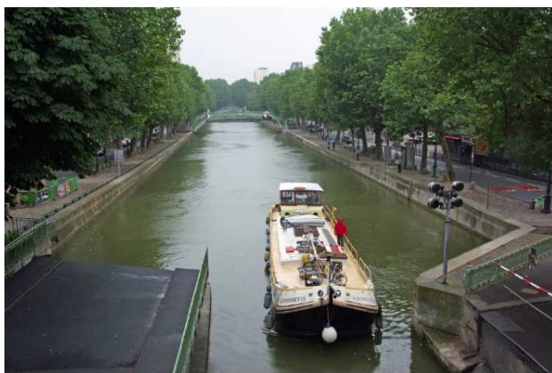
Entrée/sortie de l'écluse
