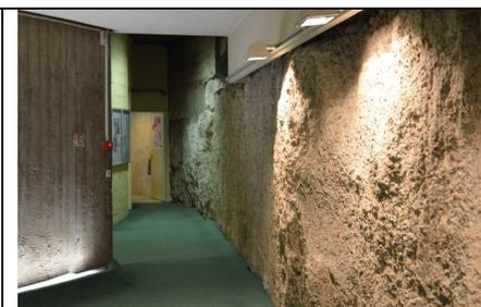
Dès l'entrée du bâtiment, mais aussi et surtout à l'intérieur, on s'aperçoit que plusieurs types de béton sont utilisés : du béton lisse, du béton moulé, du béton brut de grande qualité dont les traces de bois de coffrage sont le principal ornement avec la mise en valeur des différents types de bois utilisés et de leurs veines.
