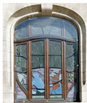
Le travail du verre avec la paraison et le travail de deux ouvriers. Le plomb souligné le dessin. Superposition des verres, parfois cinq ou six couches.
