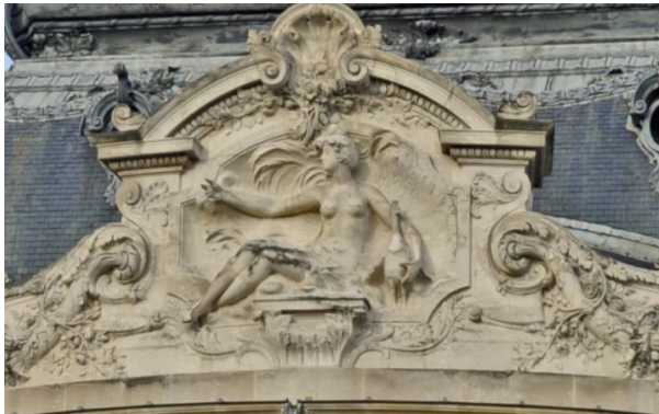
Sur façade extérieure
