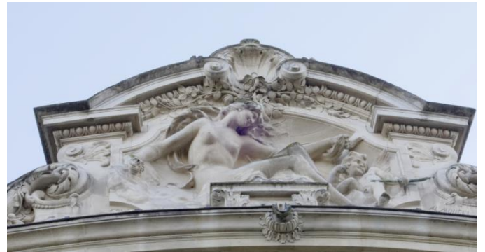
Sur façade extérieure
