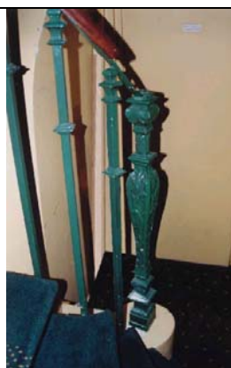
Départ de la rampe d'escalier
