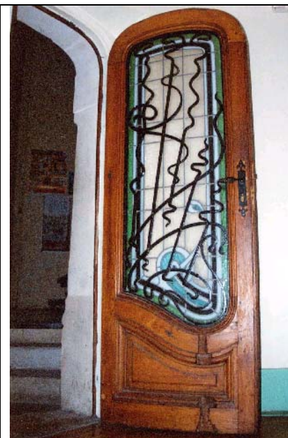
Cette superbe porte était à l'origine celle de l'ascenseur (un accessoire dont Lavirotte semble avoir équipé systématiquement ses édifices parisiens). La menuiserie en est courbe, afin d'épouser au mieux la forme du mur circulaire : une sophistication reprise plus tard par Lavirotte pour les portes palières du 29 av. Rapp.
