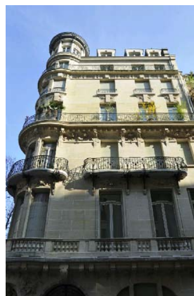
Façade côté rue de Messine
