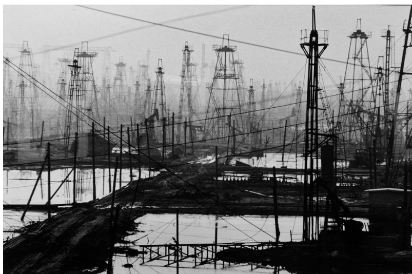
Stations de pompage de pétrole. Bakou, Azerbaïdjan, 1987.
