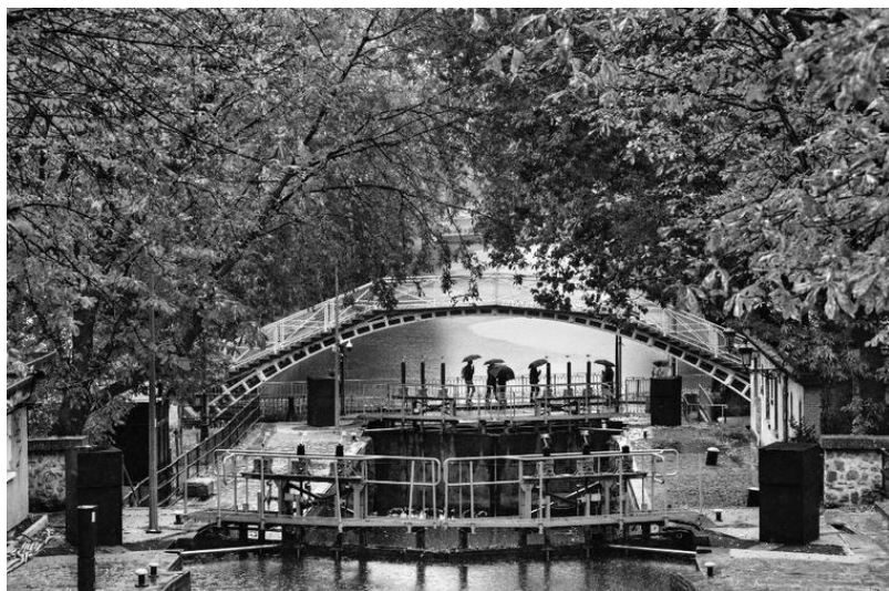
Passerelle Michèle Morgan, Canal Saint-Martin.
